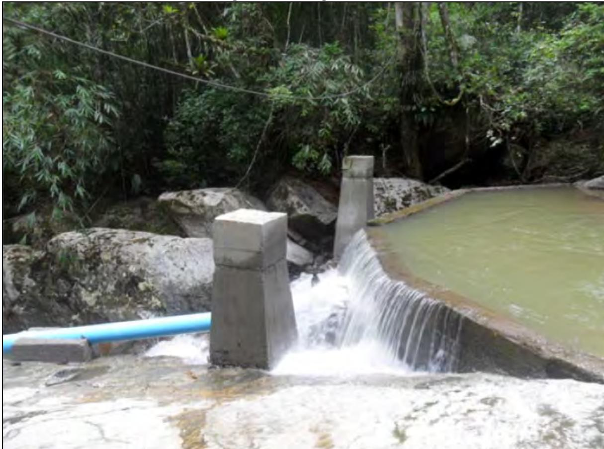
O controle das condições da barragem e da adução é realizado a partir de registros de descarga de fundo e de alimentação. A adução dá-se em dois trechos, o primeiro da captação à caixa de areia (de dimensões 11,0 x 1,10 metros) e, no segundo trecho, desta caixa até a estação de tratamento.
