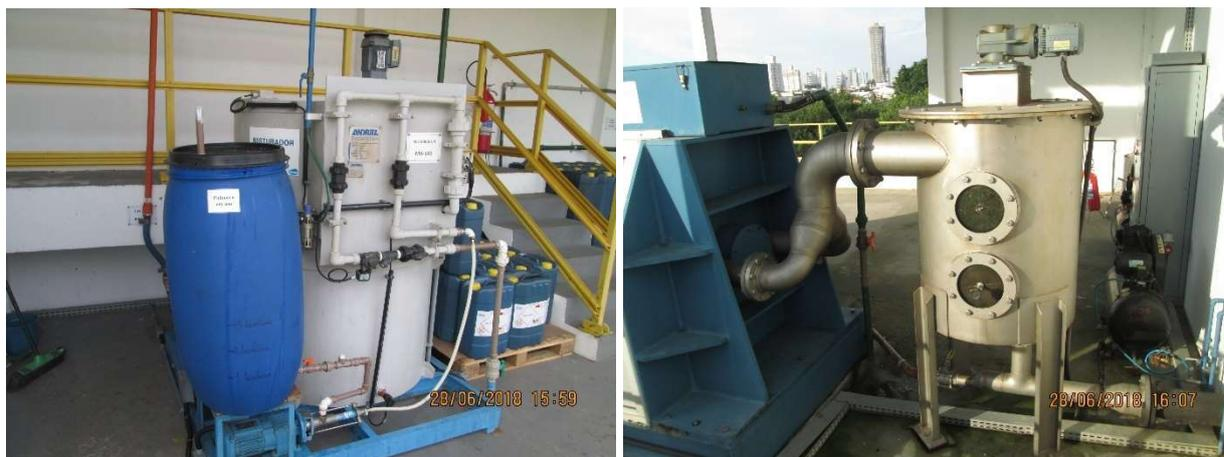
Figura 6. Registro do sistema de polieletrólito (esquerda) e formação do lodo para o descarte no Adensador (direita).
