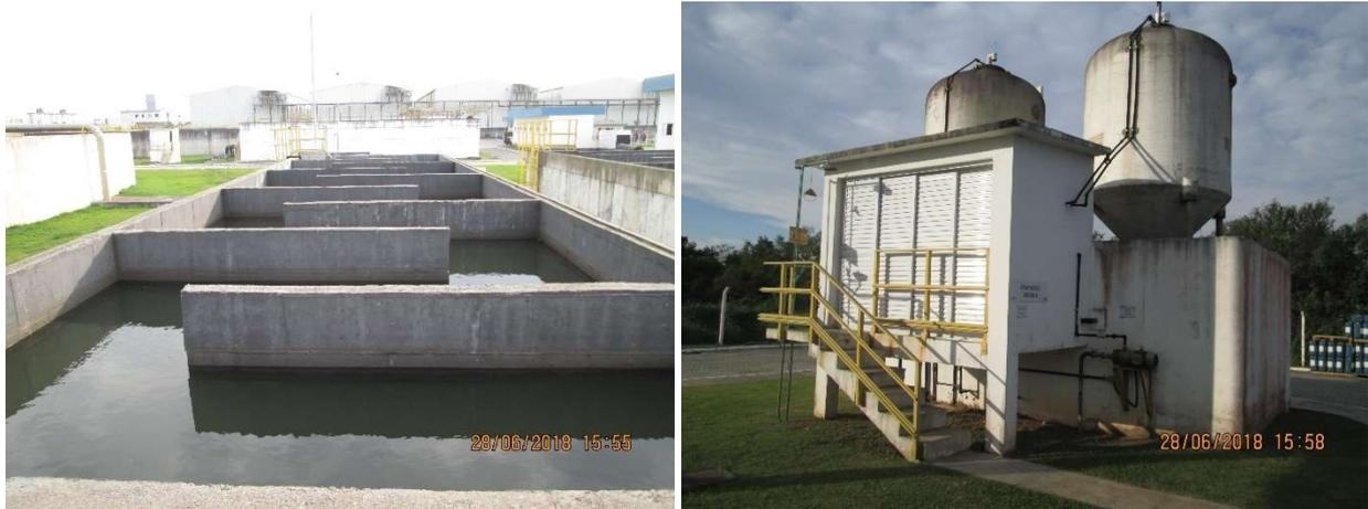
Figura 5. Registro do tanque de contato (esquerda) e reator de dióxido de cloro com respectivos tanques de *Purate* e Ácido Sulfúrico.
