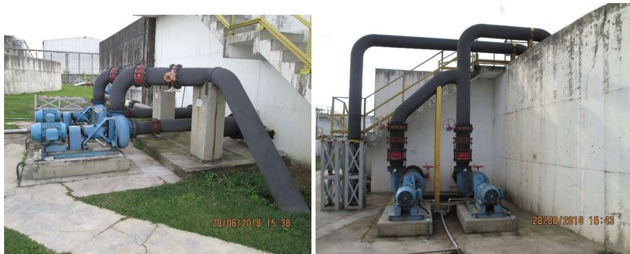
**Figura 15. Motobombas abaixo da cota de inundação**
