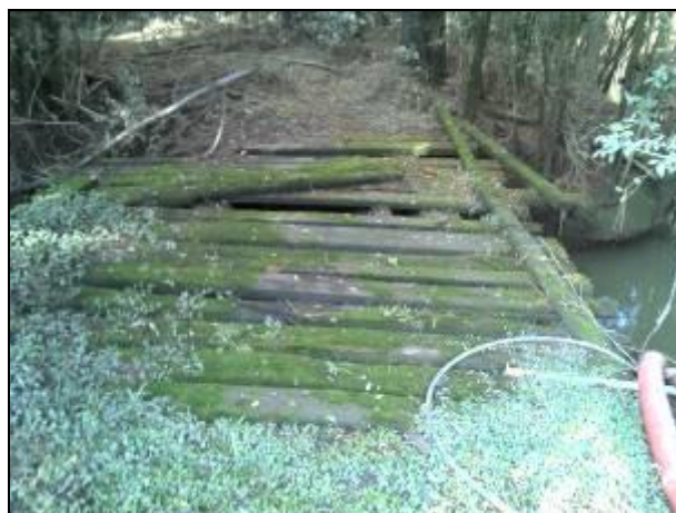
Figura 5: Ponte de acesso à captação.
