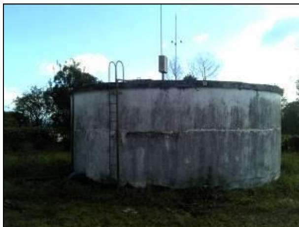
Figura 12: Escada do Reservatório R01.
