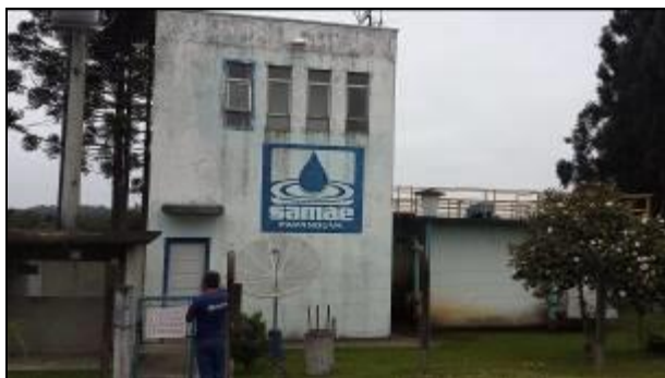
Figura 1: Imagem da ETA Salto Canoinhas onde foi coletada a água bruta.
